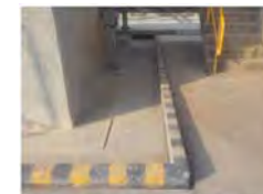
รูปที่ 3.19 พื้นที่คอนกรีตที่ลาดเอียงเข้าหาบ่อตกน้ำ (Catch Basin)
